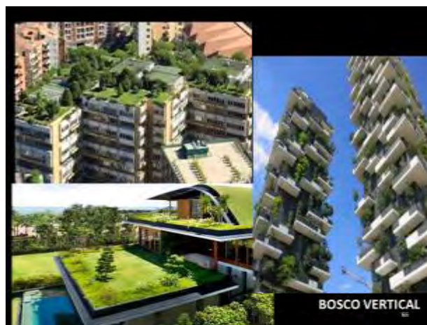
Figura 33. Cubiertas y fachadas vegetales.
