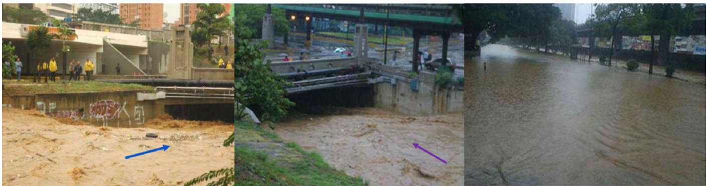
Figura 19. Efectos de la creciente del río Guaire en febrero del 2005. a) Vista de la depresión del flujo en el puente y aumento de los niveles (remanso) hacia aguas arriba (fotos izquierda y centro). b) Inundación en Bello Monte, frente a la Alcaldía de Baruta, en febrero del 2005, debido a los efectos de remanso originados por el puente Las Mercedes (Fotos extraídas de Internet).
