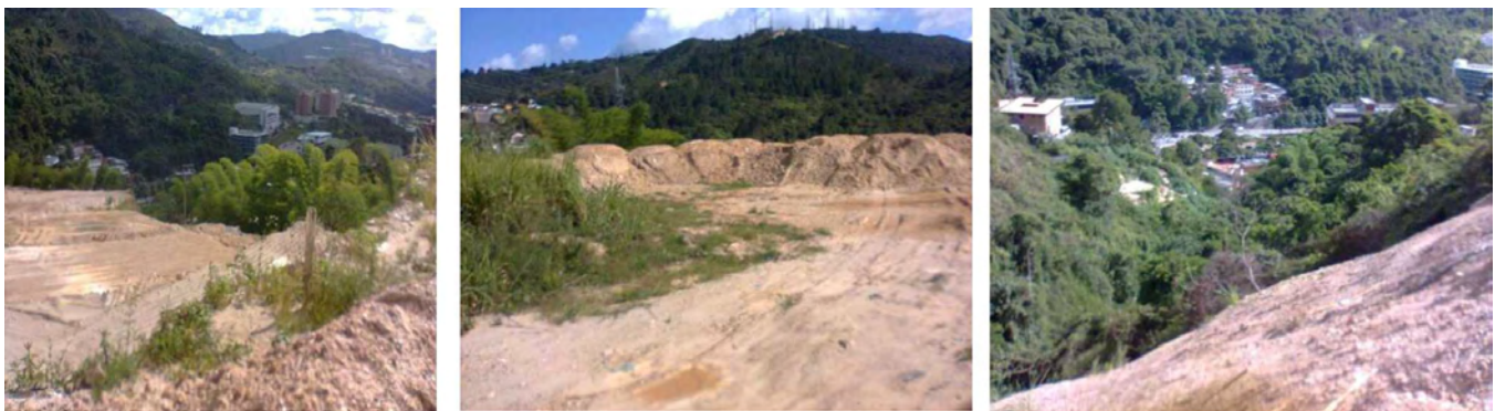
Figura 9. Movimientos de tierra y botes de escombros en taludes de la Urb. La Escondida, en la parte alta de la cuenca.
