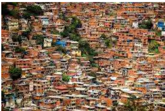
Figura 48. "...un inmenso edificio acostado sobre la montaña...". F / Google Imágenes.
