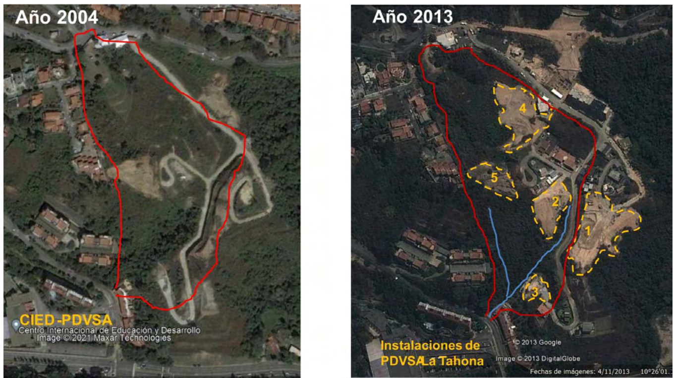
Figura 8. Vista satelital de la cuenca tributaria del pequeño afluente de la quebrada La Boyera, mostrando la situación para el año 2004 (izquierda) y para el año 2013 (derecha). En la imagen del 2013 se aprecian claramente los movimientos de tierra efectuados que causaron una sobrecarga de sedimentos durante las crecientes. Las líneas a trazos en color amarillo delimitan cinco (5) zonas donde se observan suelos desnudos por remoción de vegetación (Imágenes de Google Earth).
