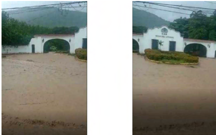
Figura 22. Vista de los desbordes del río Camurí Grande que inundaron las calles del núcleo de la USB, sede del litoral, el 28/08/21 (fotos extraídas de video de Internet).
