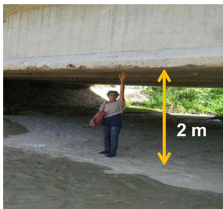
Figura 27. Vistas del puente en la Av. La Playa sobre el río San Julián. Izquierda: la luz del puente se había reducido el año 2016 a unos 2 m debido a la sedimentación del cauce, en donde la altura del canal era de 4 m. Derecha: trabajo de maquinarias removiendo la terraza sedimentaria de 2 m de espesor debajo del puente (Fotos de Mariela Gómez).
