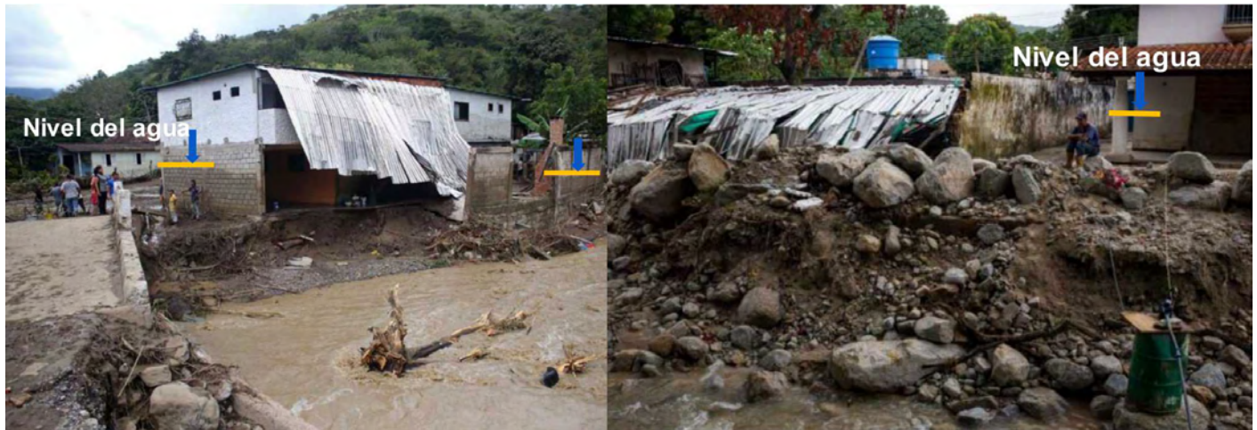
Figura 4. Marcas de agua dejadas por flujos de crecientes que escurrieron por la planicie inundable, ocupada por viviendas. Izquierda: río Zorquera el 11/11/20, en el municipio de Zorca, San Cristóbal, Estado Táchira. Derecha: río Manguito el 17/11/20 en el barrio El Pinal, en El Limón, Estado Aragua (fotografías extraídas de Internet).
