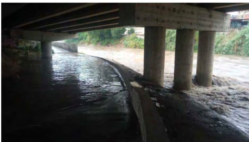
Figura 30. Desbordes del río Guaire con la tormenta del 28/07/21. Izquierda: desbordes en el Distribuidor Lebrún de la autopista en Petare; Derecha: desbordes en el Barrio La Línea en Petare. Ambos desbordes son atribuidos a la sedimentación que presenta la canalización del Guaire en este sector.
