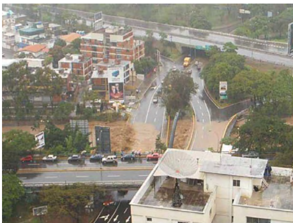
Figura 21. Inicio de la inundación del río Guaire en la California Sur en febrero 2005, causado por la contracción vertical que ejerce el puente. Observe la gran turbulencia del flujo al chocar con las vigas del tablero del puente (Fotos extraídas de Internet).
